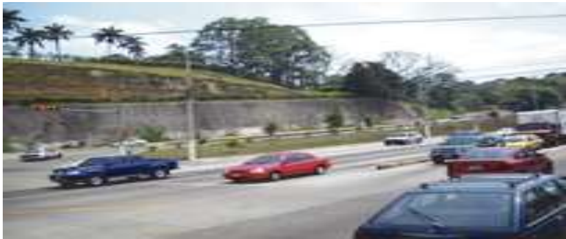
FOTO 03: ACCESO ALTERNATIVO POR BOULEVARD ORDEN DE MALTA, SANTA ELENA
