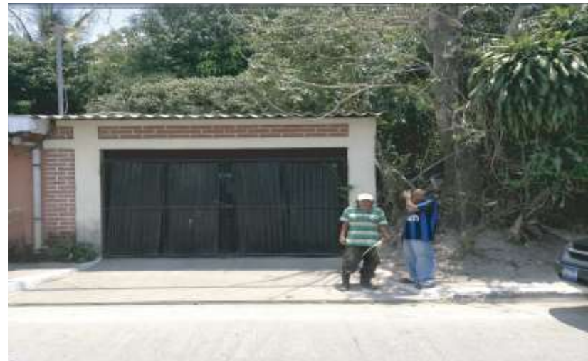
FOTO 48: VIVIENDA PARTICULAR CONSTRUIDA CON SISTEMA MIXTO
