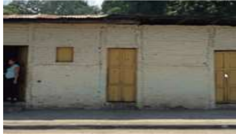
FOTO 47: VIVIENDA PARTICULAR CONSTRUIDA A BASE DE SISTEMA DE ADOBE
