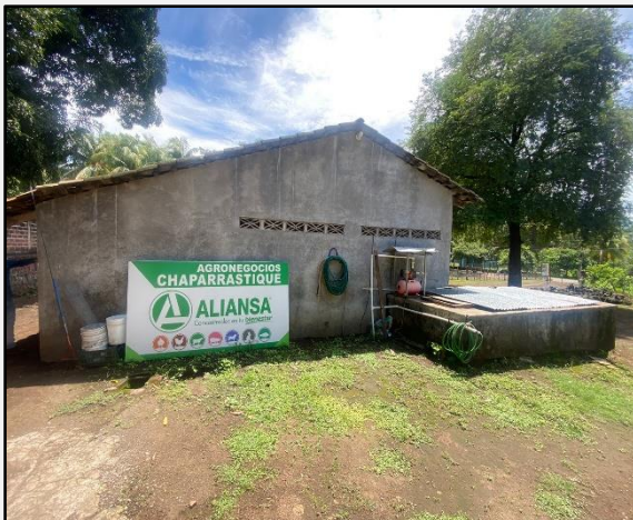
Imagen 6. Pila de abastecimiento de agua.
