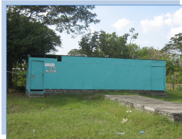
Batería de baños sanitarios provisionales.
