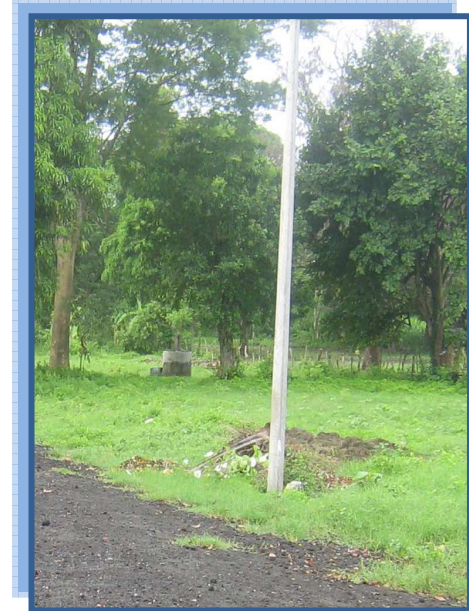
POSTE DE SERVICIO ELÉCTRICO UBICADA EN AV. ENRIQUE AGUILAR
