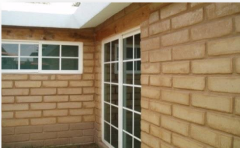
Fig. 16: Paredes de adobe
