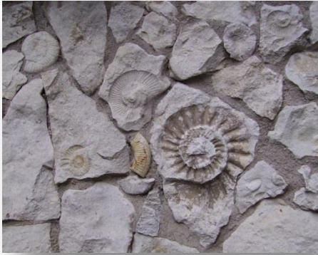
Fig. 25: Colocado de piedra
