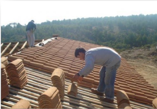
Fig. 23: Colocación de teja de barro
