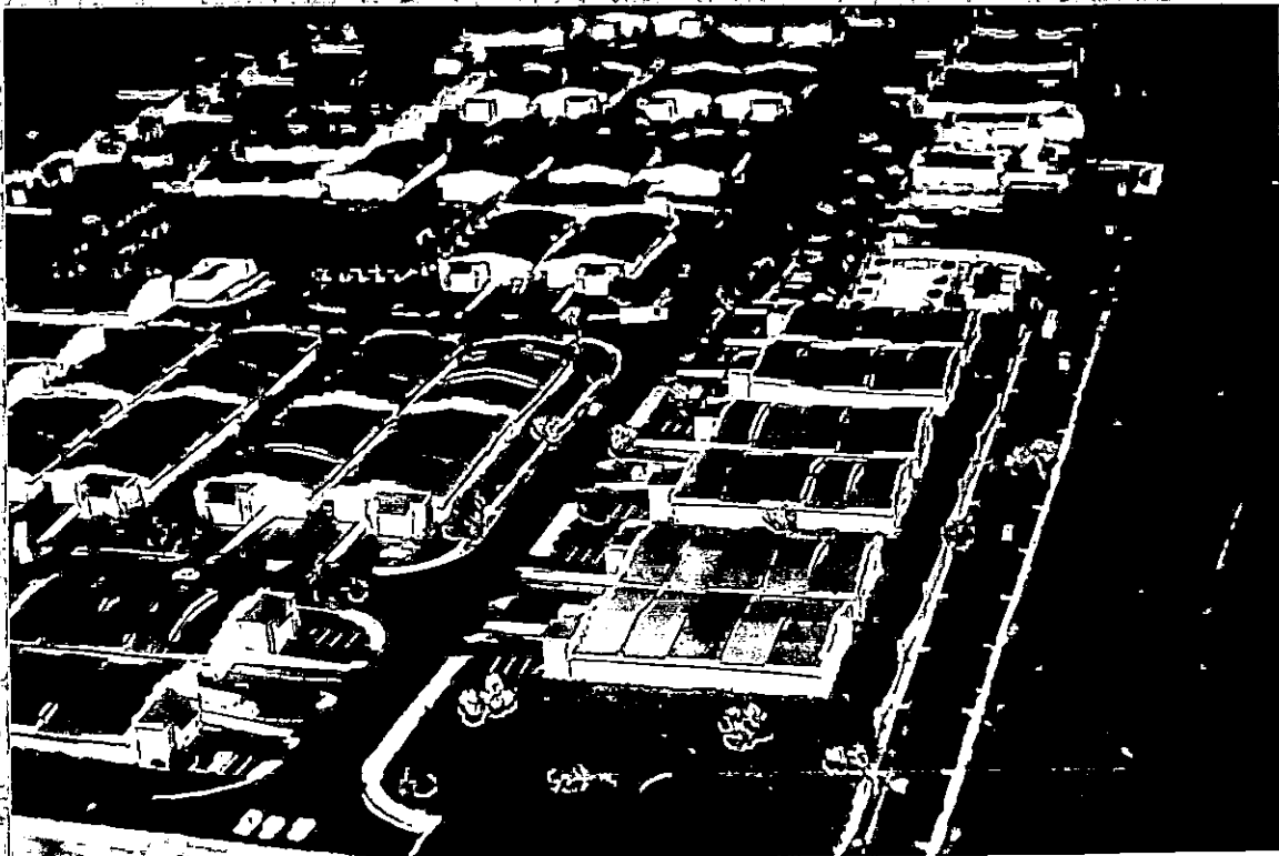
VISTA SUR - PONIENTE
