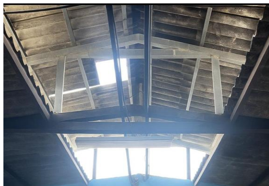
Figura A- 6. Limpieza en techo
