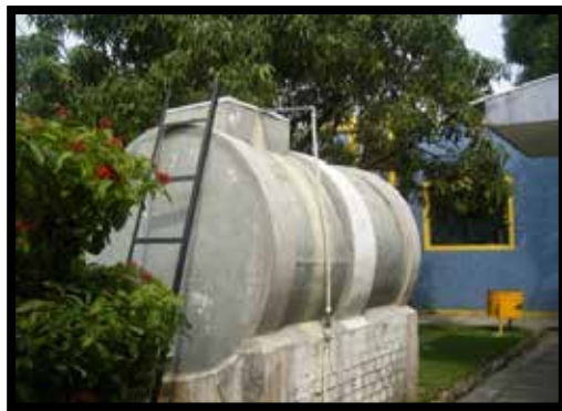
1. CISTERNA DE CONCRETO
