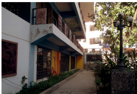
Edificio Escuela de Artes. Foto: Alejandra Ayala
