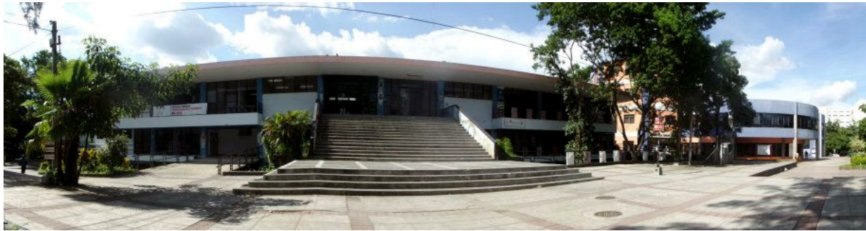
Edificio Escuela de Artes. Foto: Alejandra Ayala
