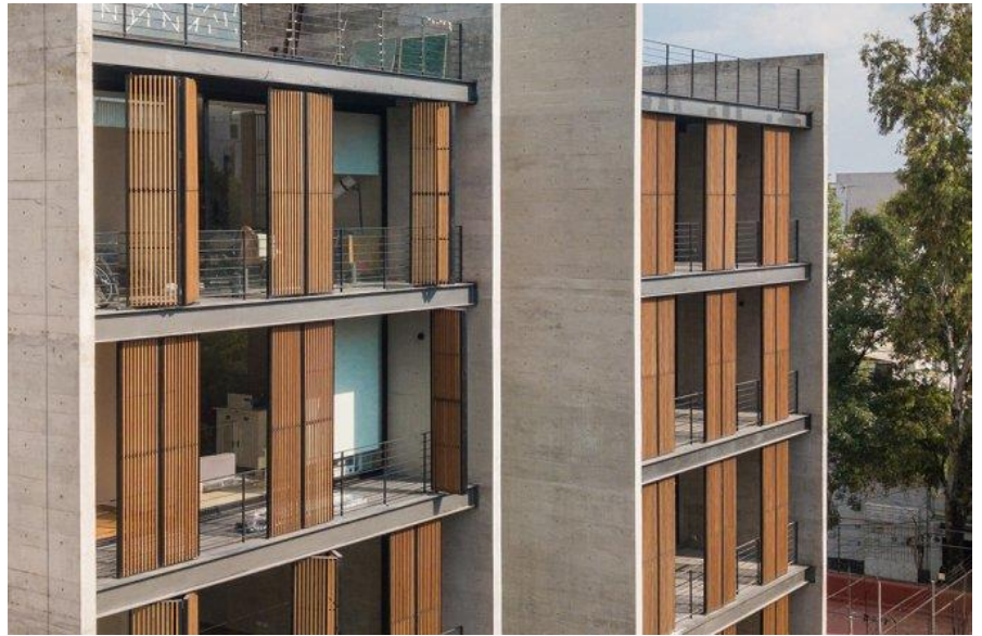
Imagen 53 Paredes de Concreto Sistema de Cortasoles y Paneles de Recubrimiento
