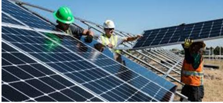
Figura 10. Montaje de sistemas solares
