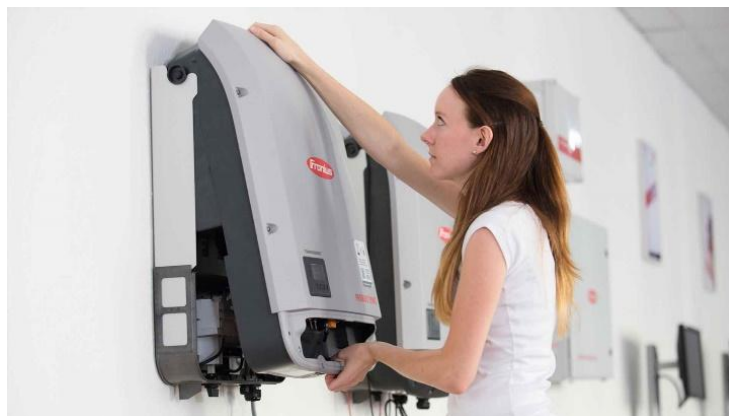
Figura 20. Módulo Fronius Primo 12.5-1 208-240
