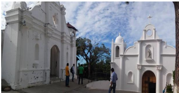
foto: ruinas de iglesia antigua y a la derecha Iglesia nueva de San Lucas Apóstol.
