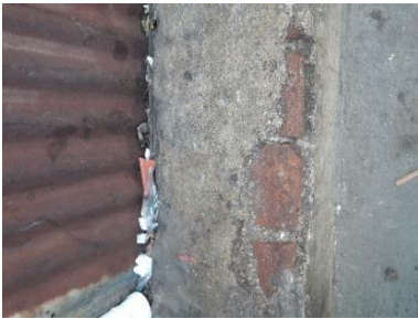
Fotografía 2: Sistema Constructivo de Ladrillo de Barro.
