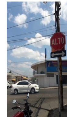
Fotografía 37: Señalización vial y peatonal inexistente, en intersección sobre 1ª Avenida Norte Fuente: Grupo Trabajo de Graduación
