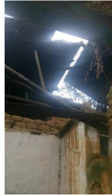
Fotografía 5: Vista de cubierta de Inmueble.
