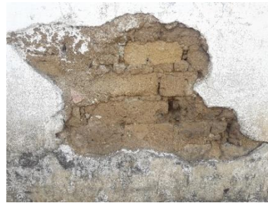
Fotografía 3: Sistema Constructivo de Ladrillo de Adobe.
