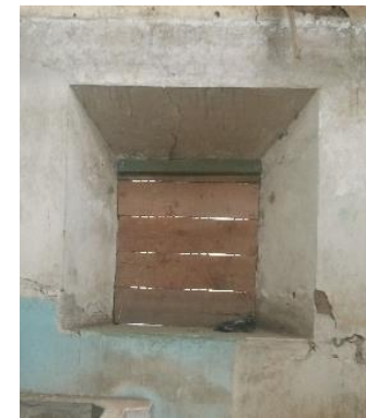
Fotografía 10: Ventana al interior de habitación (baño)
