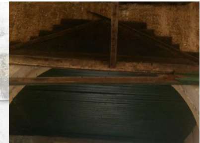
Fotografía 8: Vista Cielo Falso
