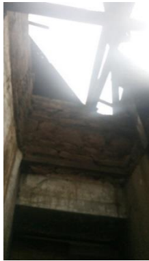
Fotografía 4: Vista de cubierta de Inmueble.
