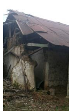
Fotografía 6: Vista de cubierta de Inmueble.
