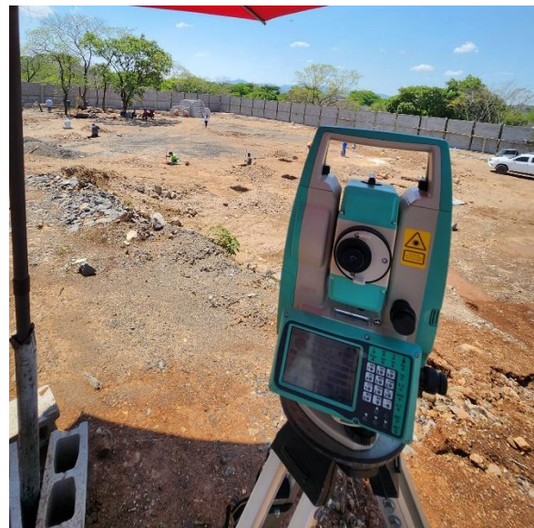
Figura 3: Obras Preliminares Casa Luz
