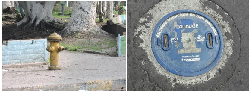
IMG320402: Infraestructura Urbana, izquierda Hidrante, derecha Pozo de Aguas Nearras
