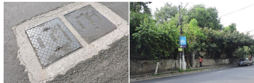
IMG320401: Infraestructura Urbana, izquierda Caja de Registro Telefónica. derecha. Poste con Luminaria.
