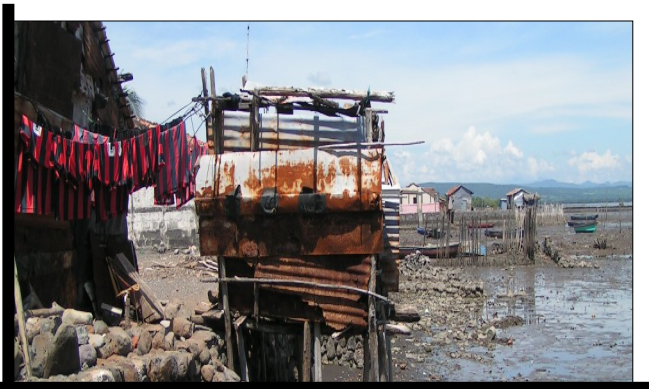
Foto N° 1: Casa ubicada en el frente de playa
