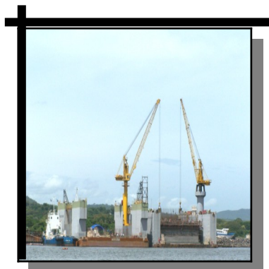
Foto N° 8: Construcción del Puerto de La Unión.
