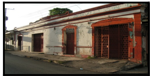
Foto N°33: Vivienda Construidas de adobe.
