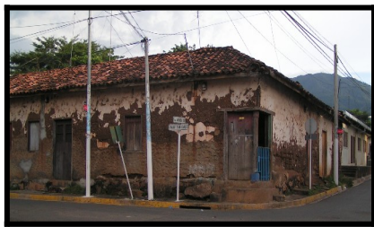
Foto N°32: Vivienda Construidas de adobe.
