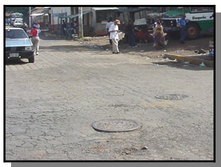
Foto N°59: Ubicación de pozo de aguas negras
