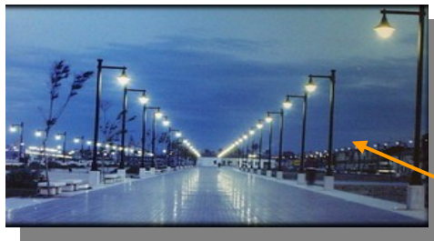
Foto N°76: Postes de Energía Eléctrica propuestos.
