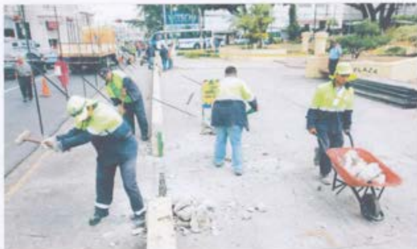
Los trabajos de restauración de la Plaza Francisco Morazán comenzaron ayer. FOTO EPH / CORTESÍA ALCALDÍA DE SAN SALVADOR
