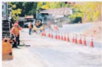
Los conductores y residentes en la zona esperan que los trabajos reparados duren mucho tiempo. FOTOGRAFÍA: NISY MORALES
