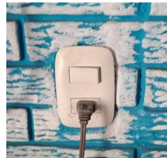
LUMINARIAS E INTERRUPTORES BIEN, TOMACORRIENTES A PROCESO DE CAMBIO
