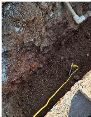
PRUEBA DE RED DE TIERRA: Valor de resistencia de tierra fuera de norma.
