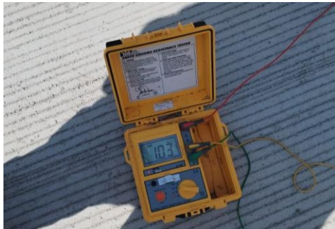
PRUEBA DE RED DE TIERRA QUE SI CUMPLE
