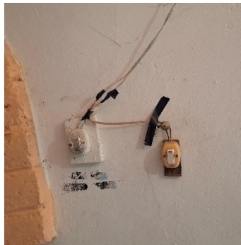
LUMINARIAS, INTERRUPTORES Y TOMACORRIENTES EN MAL ESTADO QUIERER CAMBIO
