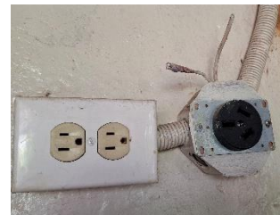
LUMINARIAS, INTERRUPTORES Y TOMACORRIENTES VIEJO FUNCIONAL REQUIERE CAMBIO
