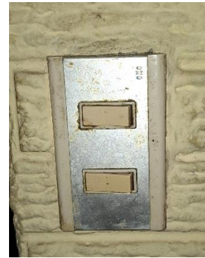
LUMINARIAS, INTERRUPTORES Y TOMACORRIENTES EN MAL ESTADO QUIERER CAMBIO
