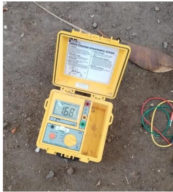
PRUEBA DE RED DE TIERRA QUE CUMPLE
