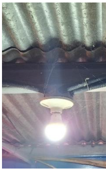
LUMINARIAS, INTERRUPTORES Y TOMACORRIENTES EN MAL ESTADO QUIERER CAMBIO
