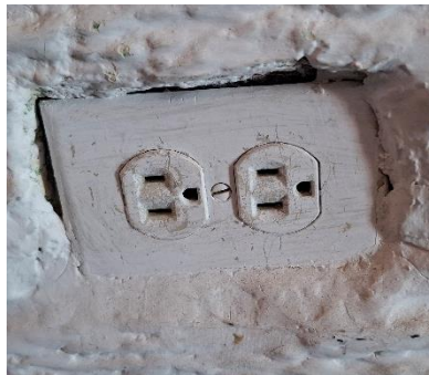
LUMINARIAS E INTERRUPTORES BIEN, TOMACORRIENTES A PROCESO DE CAMBIO
