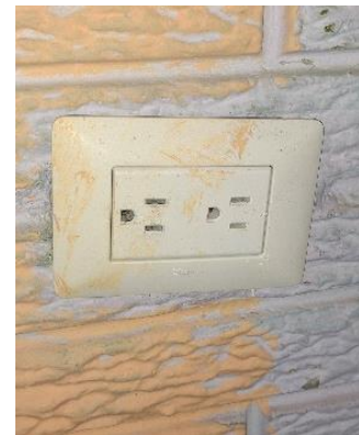
LUMINARIAS FUNCIONAL, TOMACORRIENTES E INTERRUPTORES YA DESFASADADOS
