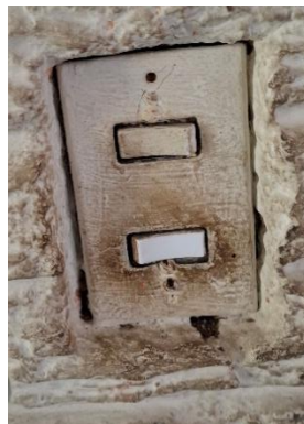
LUMINARIAS FUNCIONAL, TOMACORRIENTES E INTERRUPTORES YA DESFASADADOS
