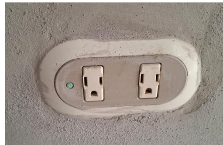
LUMINARIAS, INTERRUPTORES Y TOMACORRIENTES EN MAL ESTADO QUIERER CAMBIO
