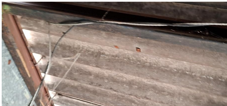
UNA PARTE CARECE DE CANALIZACION
