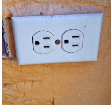
LUMINARIAS, INTERRUPTORES Y TOMACORRIENTES VIEJO FUNCIONAL REQUIERE CAMBIO
