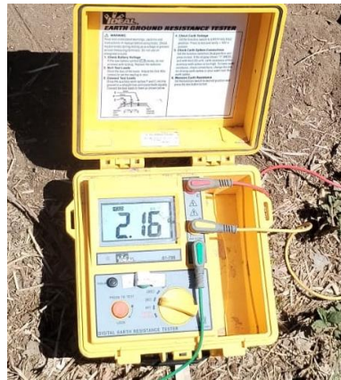
PRUEBA DE RED DE TIERRA QUE CUMPLE
