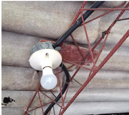
LUMINARIAS, INTERRUPTORES Y TOMACORRIENTES VIEJO FUNCIONAL REQUIERE CAMBIO
