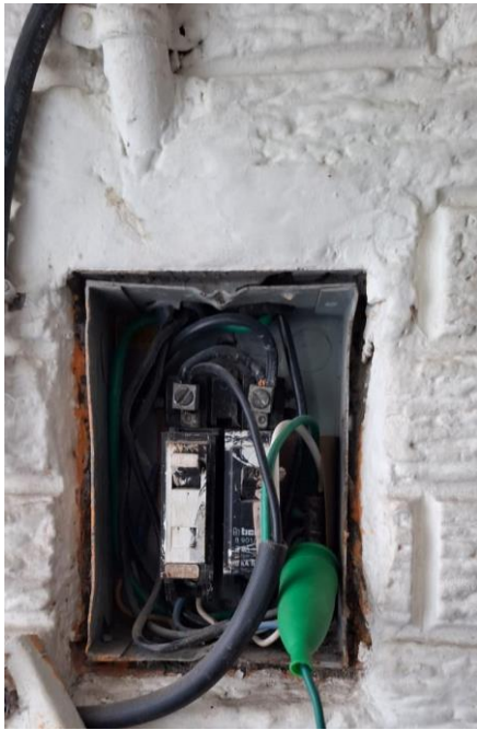
Imagen 3. Centro de carga o caja térmica de una vivienda de los años 1980. interruptores
