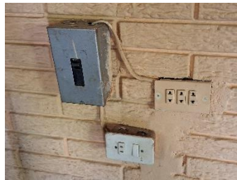
LUMINARIAS, TOMACORRIENTES E INTERRUPTORES YA DESFASADADOS
