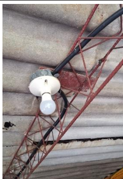
CANALIZACION EN BUEN ESTADO
