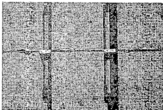
Fig.2.93 Forma correcta de colocar las pasajuntas.
