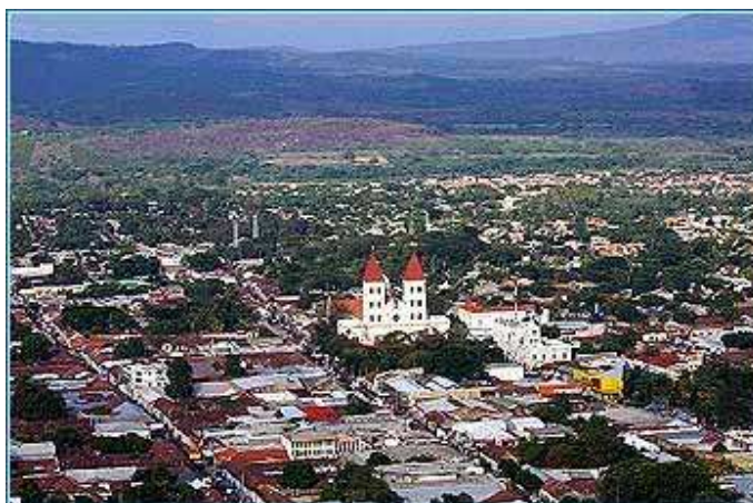
Figura N° 1.2: En la fotografía se puede observar una vista aérea del Centro Histórico de la Ciudad de San Miguel, incluyendo la Imponente Estructura de Catedral Basílica de Nuestra Señora de La Paz.
