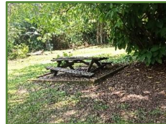
Foto 15. Mobiliario en deterioro
