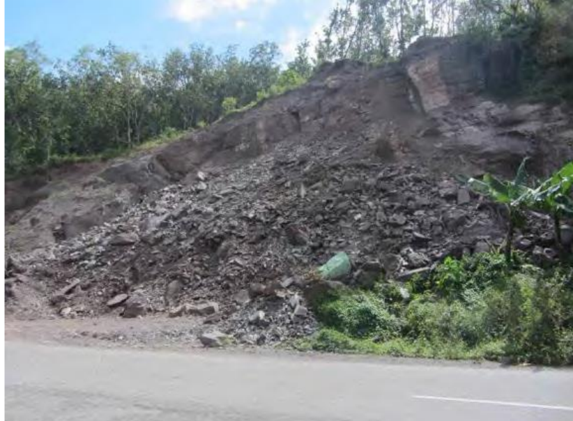
Figura 12. Afloramiento de la capa Subinal, carretera a Esquipulas (Fuente: (UNESCO-PHI/UICN, 2016)).
