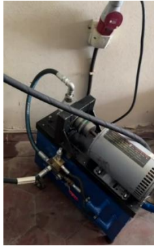
Figura 199. Puesta en marcha del equipo para verificar fugas en el tanque de aceite hidráulico
