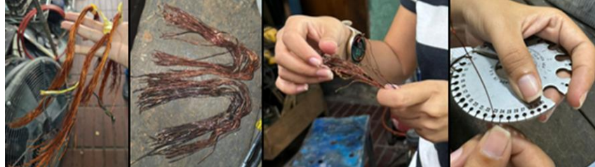
Figura 149. Remoción de bobinas quemadas
