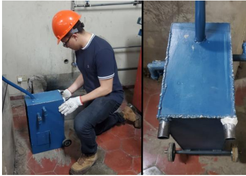
Figura 162. Aplicación de pegamento epóxico en los cordones de soldadura de las patas del tanque hidráulico
