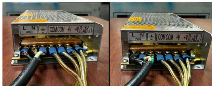
Figura 173. Reubicación y encintado del cableado de alimentación
