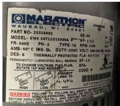
Figura 141. Placa de datos técnicos, motor trifásico
