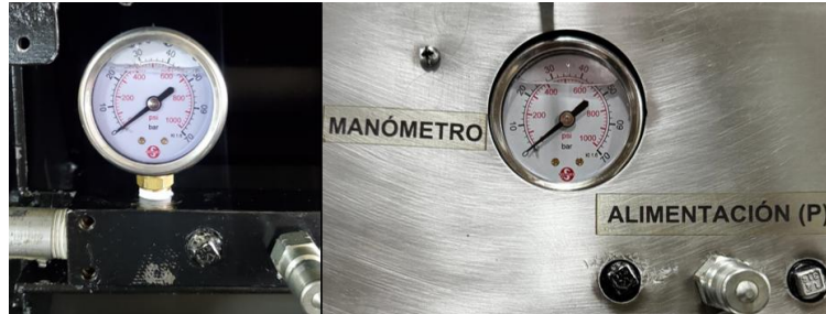
Figura 182. Instalación del manómetro ubicado en la estructura metálica
