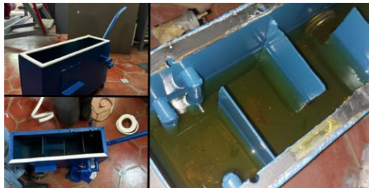
Figura 165. Cambio de empaques del tanque de aceite hidráulico
