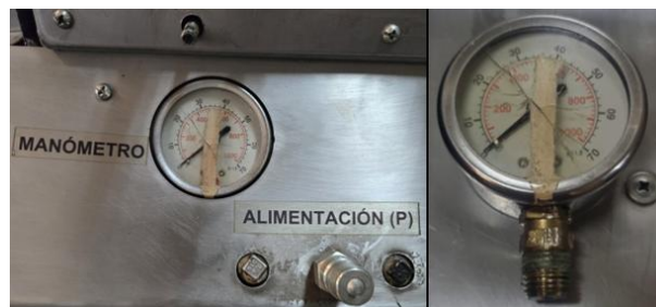
Figura 180. Desinstalación del manómetro ubicado en la estructura metálica
