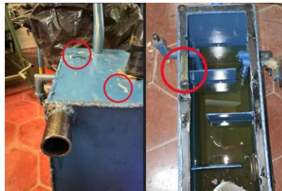
Figura 75. Verificación de la estructura del tanque de aceite hidráulico
