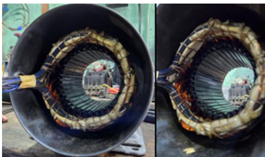
Figura 155. Bobinado con el cableado de las 6 líneas
