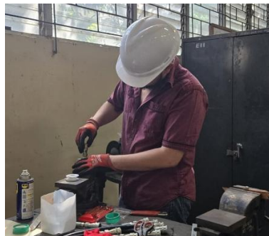
Figura 177. Conexión de acoples rápidos y mangueras hidráulicas
