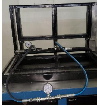
Figura 210. Puesta en marcha de los manómetros
