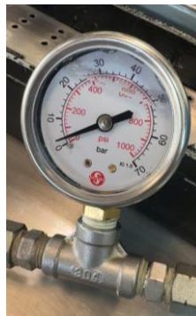
Figura 183. Instalación de manómetro ubicado en un conector en T
