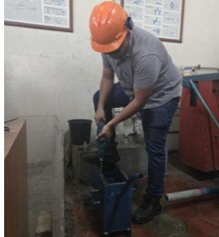
Figura 166. Taladrado de los agujeros de sujeción de la bomba al tanque
