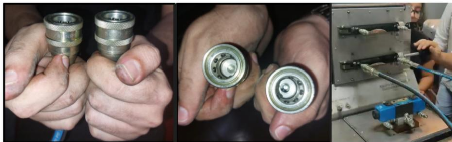
Figura 123. Inspección de conexiones
