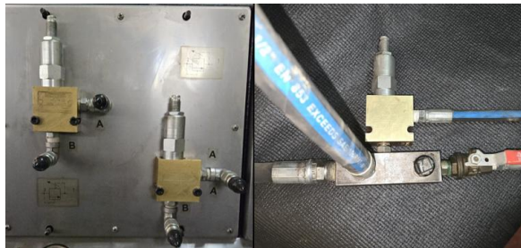
Figura 130. Desmontaje y desconexión de los bloques manifold
