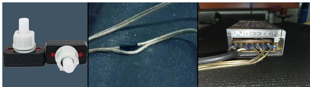
Figura 119. Inspección de conexiones, cableado e interruptores
