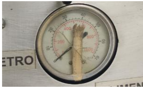
Figura 138. Inspección de la carátula del manómetro
