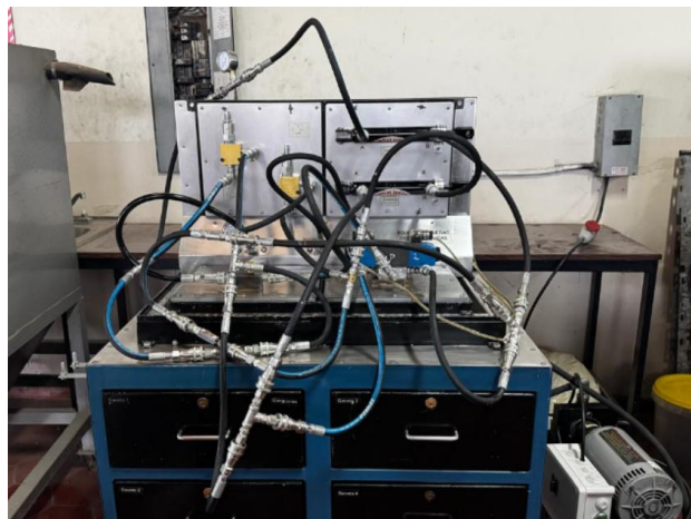
Figura 225. Construcción del circuito hidráulico de prueba 6
