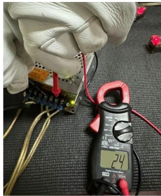
Figura 120. Medición del voltaje de salida sin carga
