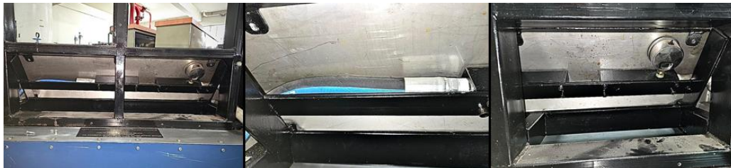
Figura 88. Inspección estructura base interna, soldadura y manifolds
