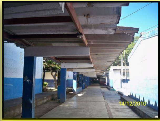
Imagen N°43 Pasillos hacia área de Talleres
