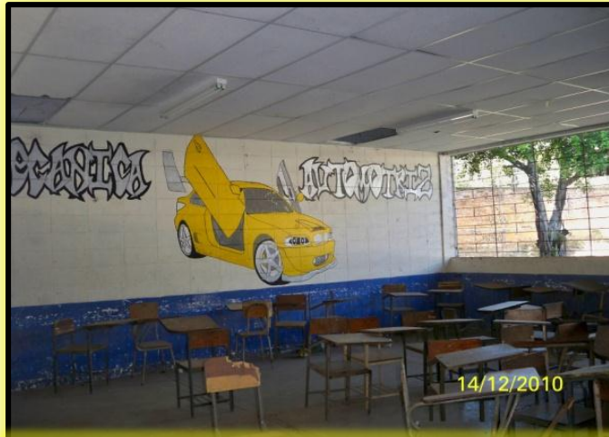
Imagen N°36 Interior de Aula Pabellón de Automotores
