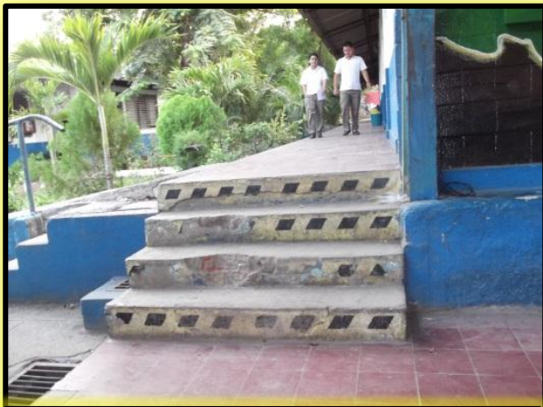
Imagen N°42 Gradas de Pabellón B
