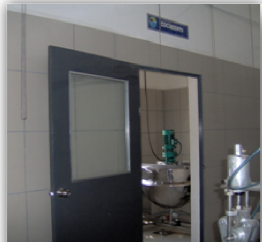
Puertas de fácil limpieza en Area de Proceso
