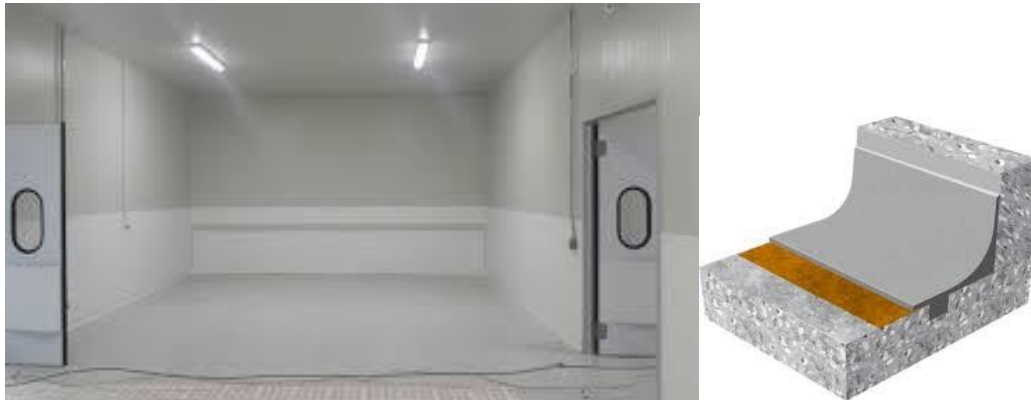
Figura 6. Paredes blancas y lisas. Curva sanitaria.
