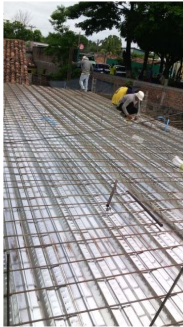
Figura 16: Armado de una losa de Metal Deck.
