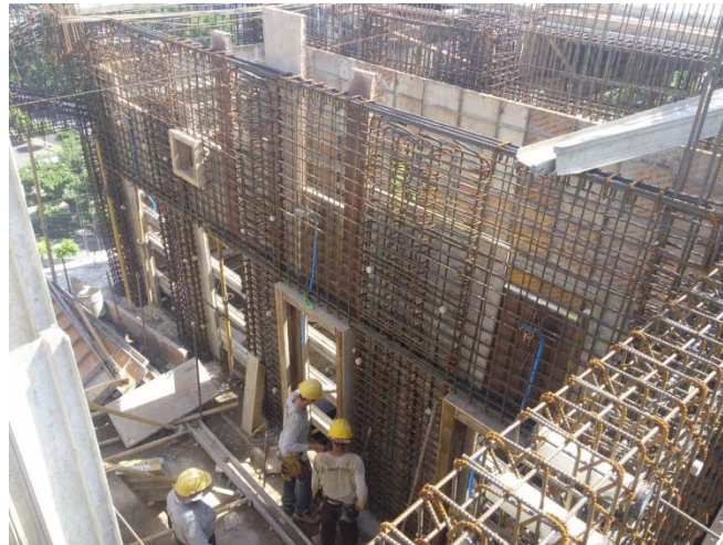
Figura 2: Muros estructurales de concreto (Yesenia Recinos).
