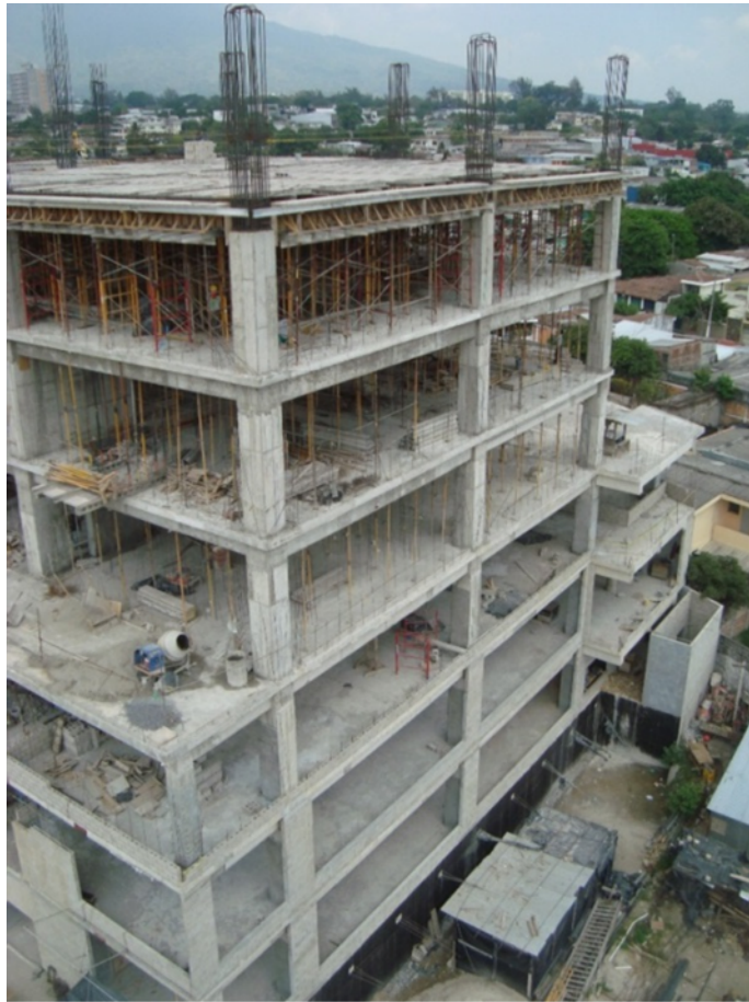
Figura 1: Marcos de concreto estructurales (Yesenia Recinos).
