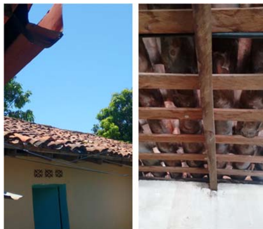
Figura 19: Sistema de techo de teja.
