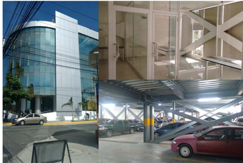
Figura 8: Edificio a base de marcos de acero arriostrados concéntricamente (Edificio de la Corte Suprema de Justicia).
