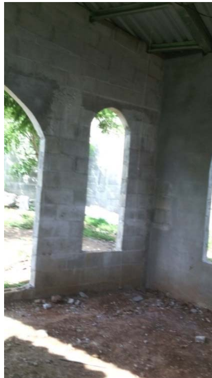
Figura 6: Mampostería con refuerzo integral.
