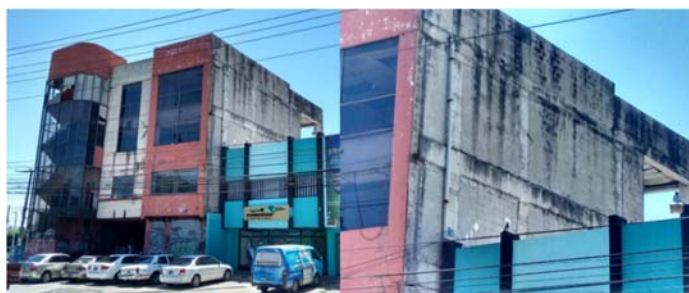
Figura 12: Edificio a base de marcos de concreto reforzado combinados con paredes de mampostería de bloque de concreto.
