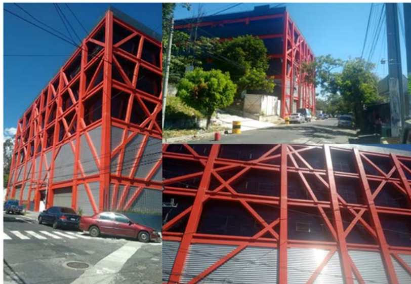
Figura 9: Edificio a base de marcos de acero con arriostramiento excéntrico (Edificio Roma, Zona Financiera).
