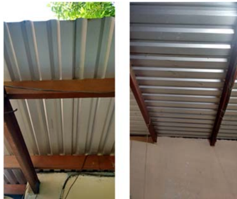
Figura 18: Sistema de techo de lámina Zinc-Alum.
