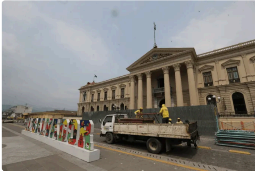
Frente al Palacio se localizan varios camiones del MOP junto a trabajadores que mueven diversos materiales. El inmueble ha sido cerrado temporalmente, según el ministerio de Cultura desde el 10 de abril, por trabajos de mejora, mantenimiento y restauración. Foto: Julio Umaña
