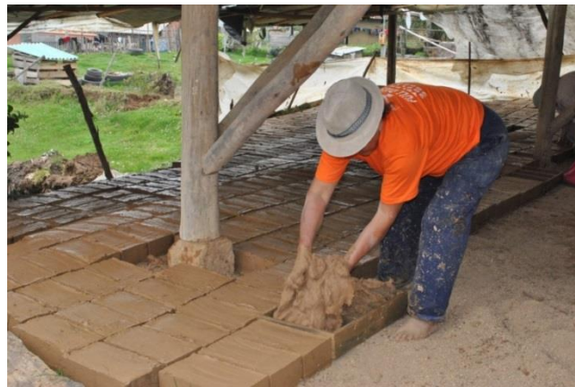
Fig. 17 – Obrero elaborando ladrillos de arcilla con moldes de madera.
