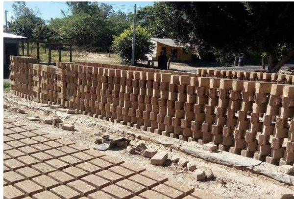
Fig. 23 – Espacio de taller de la ladrillera estudiada. Fotografía: Grupo Investigador
