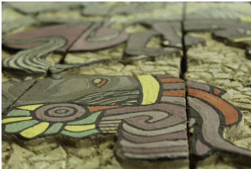
Fig. 45 – Detalle de superficie de ladrillo crudo coloreado con engobes / Fotografía por grupo investigador.
