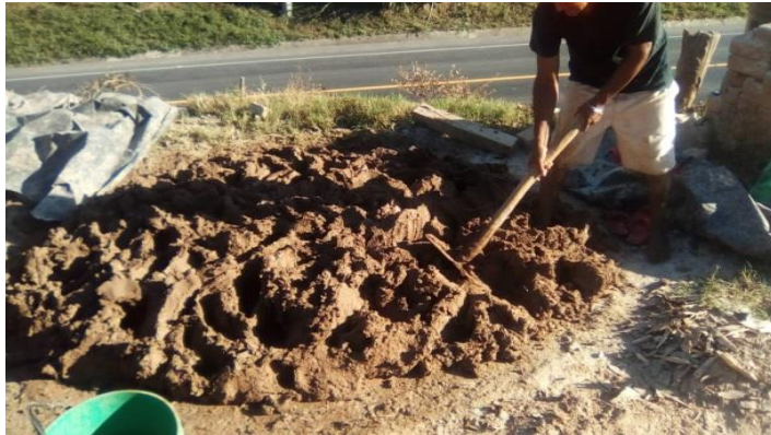
Fig. 30 – Mezclado de materias primas. / Fotografía por grupo investigador
