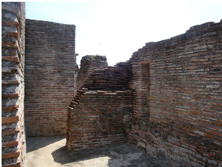
Fig. 7 – Vista interior / pirámides con ladrillo y estuco.
