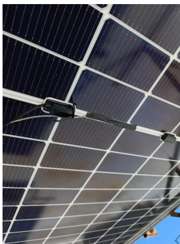
Ilustración 46 Termopar tipo K instalado
