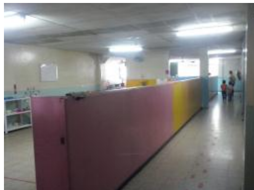
Pasillos despejados con necesidad de antideslizante cada cierto tramo para seguridad de los niños.
