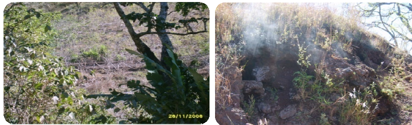
EROSION DEL TERRENO Y ESTRATIGRAFIA INESTABLE CON LLACIMIENTO DE VAPOR.
