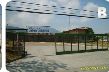
B. POLIGONO DE TIRO AL ARCO, este colinda con el terreno.
