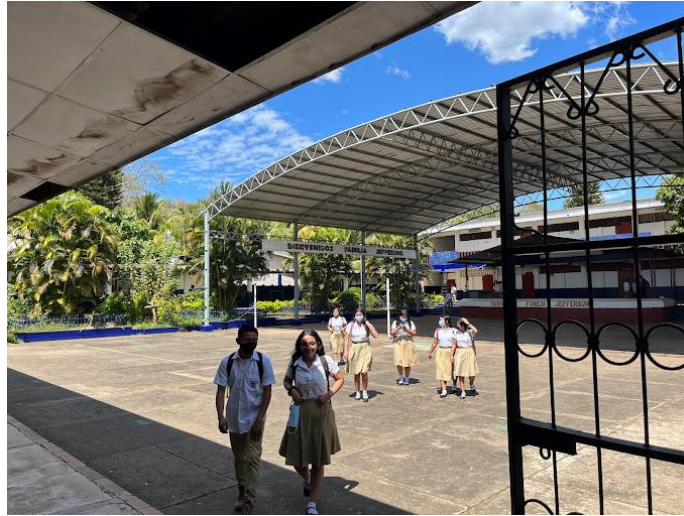
FIG. 2. Instalaciones del instituto nacional thomas jefferson, extraído de: https://www.elsalvador.com/noticias/nacional/cierra-instituto-sonsonate-trabajos-infraestructura/1007848/2022/
