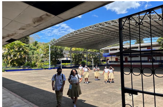
Figura 2. Instalaciones del instituto nacional thomas jefferson, extraído de: https://www.elsalvador.com/noticias/nacional/cierra-instituto-sonsonate-trabajos-infraestructura/1007848/2022/
