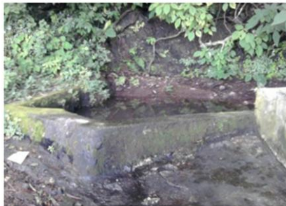
Figura 16. Fotografía de obra de captación de manantial de Ojushte, Municipio de San Miguel de Mercedes, Departamento de Chalatenango.
