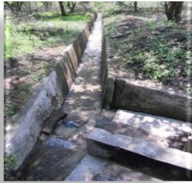
Foto # 17 Desalojo de Aguas Lluvias
