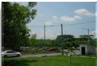
Foto # 10 Sistema de Instalaciones Eléctrica
