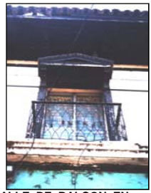
DETALLE DE BALCON EN VOLADIZO
