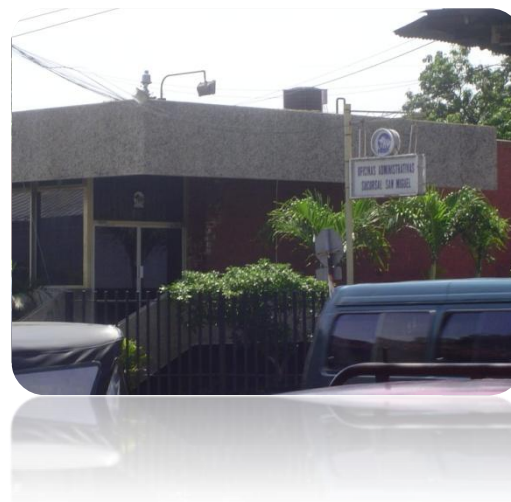
FOTO No 29: Edificio del Seguro Social. FUENTE: Visita de campo del grupo de trabajo
