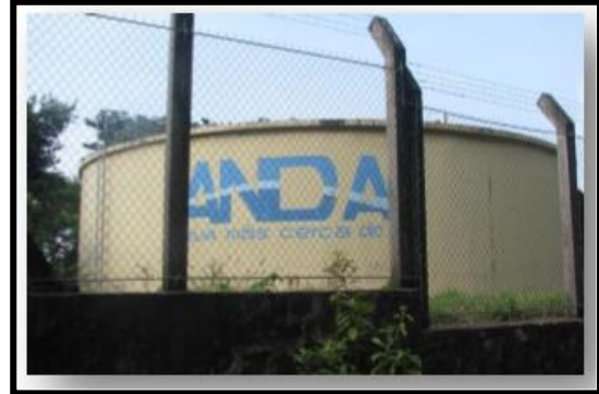
F-3.40. Tanque de agua potable. Fuente Propia.
