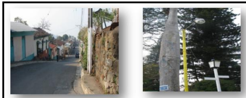
F-3.39. Alumbrado eléctrico y decorativo. Fuente
