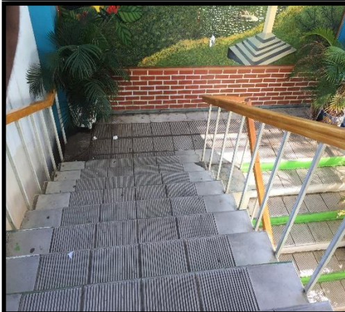
F-3.38. Interiores de la municipalidad segundo nivel. Fuente Propia.
