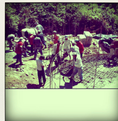
Imagen No. 4: Construcción de un Tanque de Captación de Agua. Comunidad Bolívar
