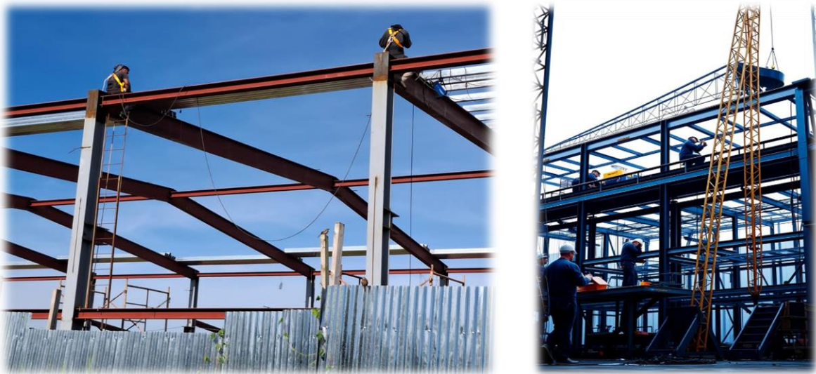
Ilustraciones 15: Montaje de estructuras metálicas
