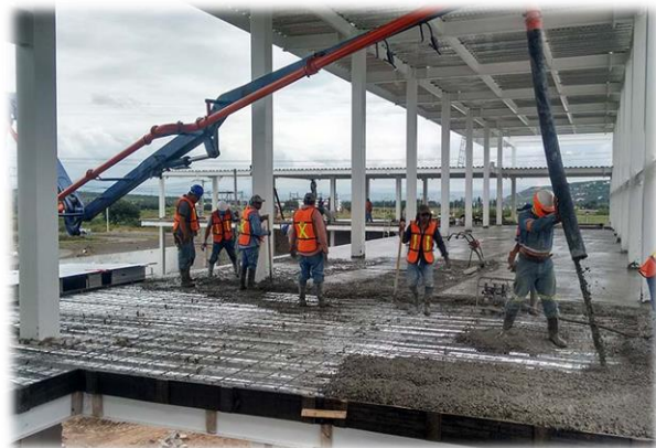
Ilustración 33: Colado de Losa.
