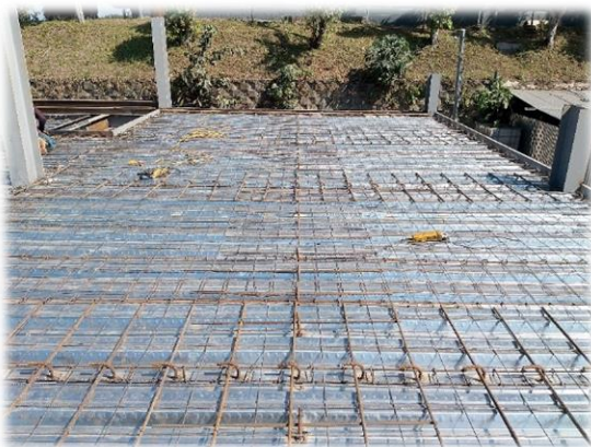
Ilustración 32: Instalación de losa Galvadeck y armadura.
