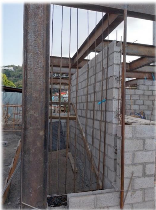
Ilustraciones 34: Construcción de paredes
