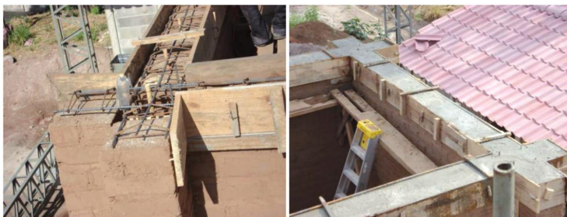
Figura 4.4-1 Detalle del Acero de Refuerzo – Colado de SC (PROYECTO TAISHIN, 2,008)
