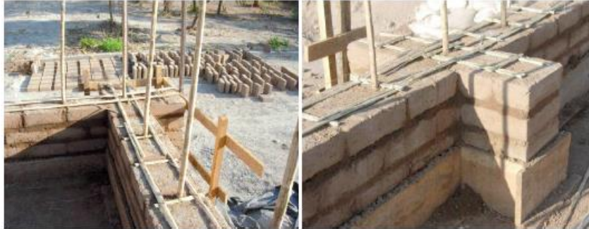
Figura 2.4-1 Colocación de refuerzo en vivienda de adobe mejorado
