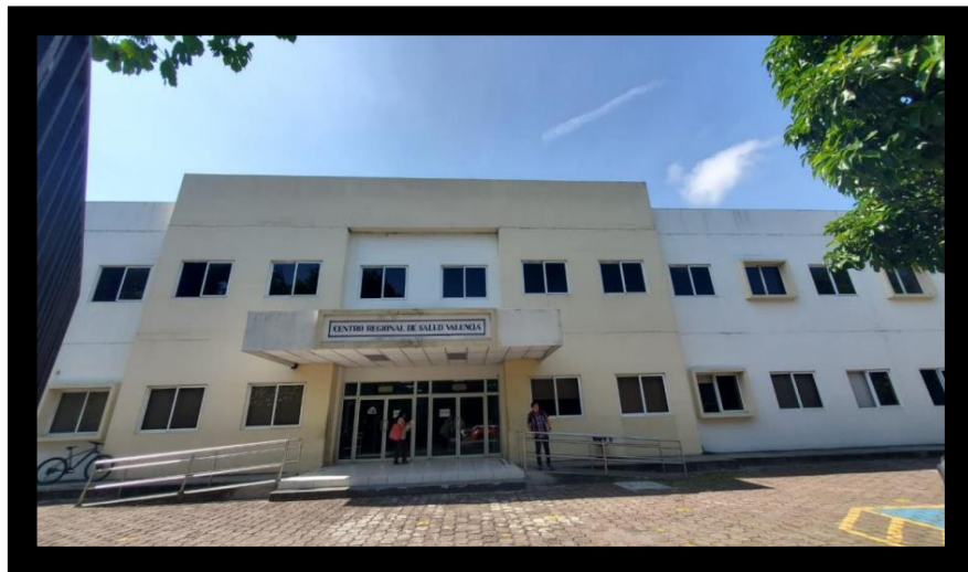
Ilustración 13. Fachada Centro Regional de Salud Valencia
