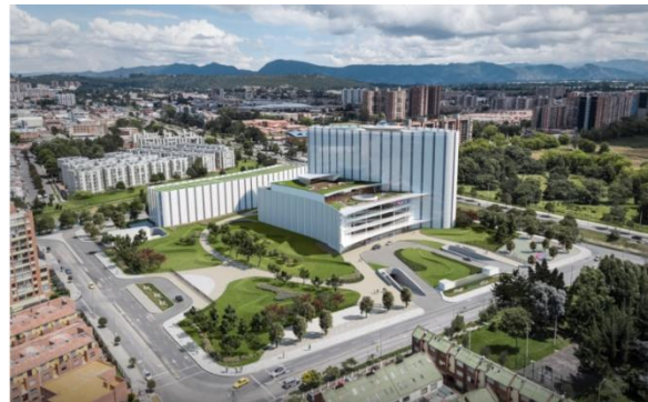
Fig. 7. Vista frontal del edificio, imagen obtenida de “Construcciones Planificadas S.A.”. Recurso digital: https://n9.cl/kukmkb
