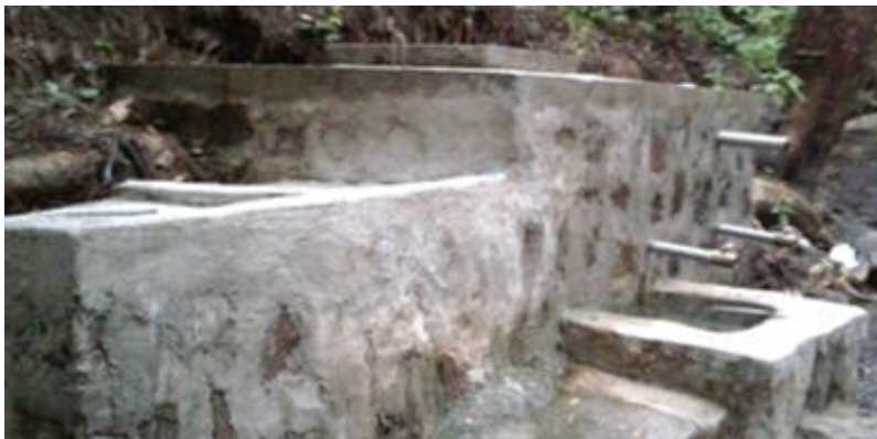
Figura 3: Pozo Centro del Bajío (P2)
