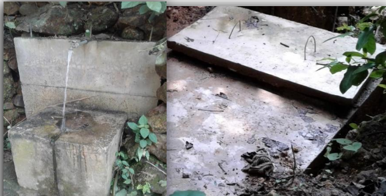
Figura 6: Pozo Carasque, calle a Nueva Trinidad (P5)
