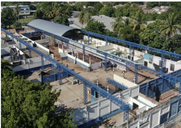
Imagen 1: Vista aérea de la colocación de la cubierta de techo
