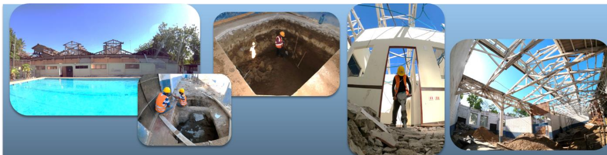
Imagen 3: Vista aérea de la colocación de la cubierta de techo
