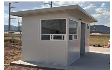
Imagen 4. Caseta de vigilancia
