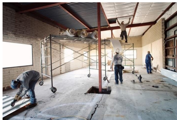
Imagen 11. Ejemplo de montaje de cubierta de techo
