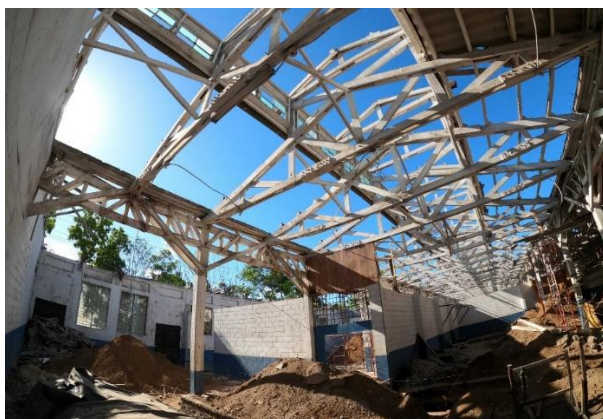
Imagen 10. Desmontaje de cubierta de techo y demoliciones en el proyecto
