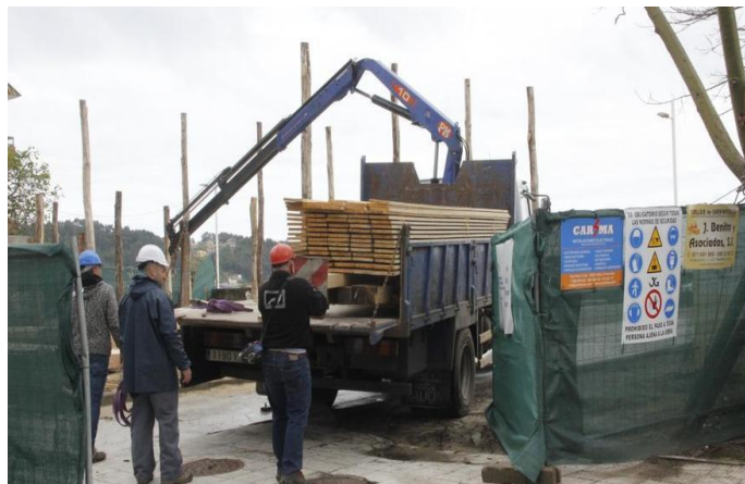
Imagen 9. Descarga de materiales en zona destinada para acopio de materiales
