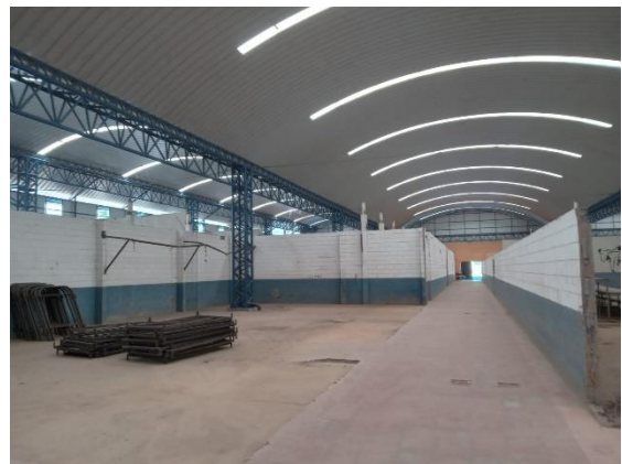
Imagen 2: Vista interna de cubierta, y estructura de techo
