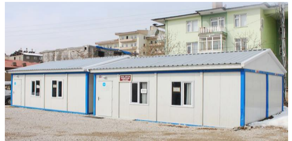
Imagen 6. Bodega prefabricada para oficinas y almacenaje de materiales
