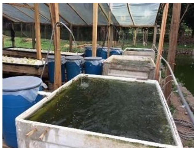
Figura 13. Sistema de aireación.
