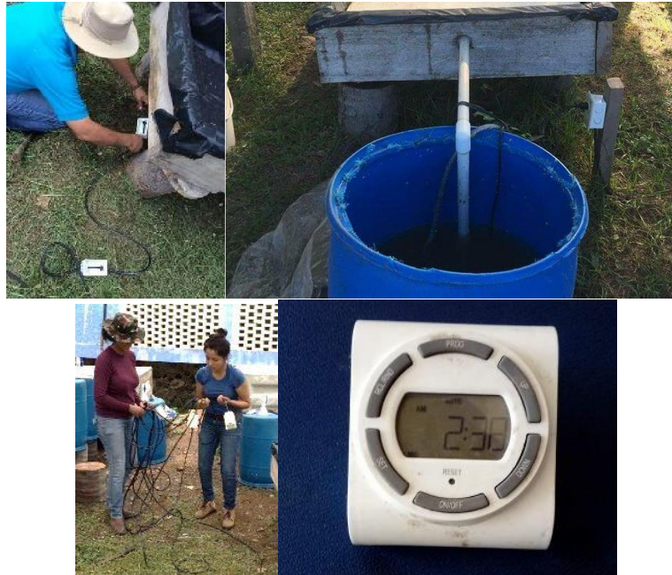
Figura 12. Instalación del sistema eléctrico.
