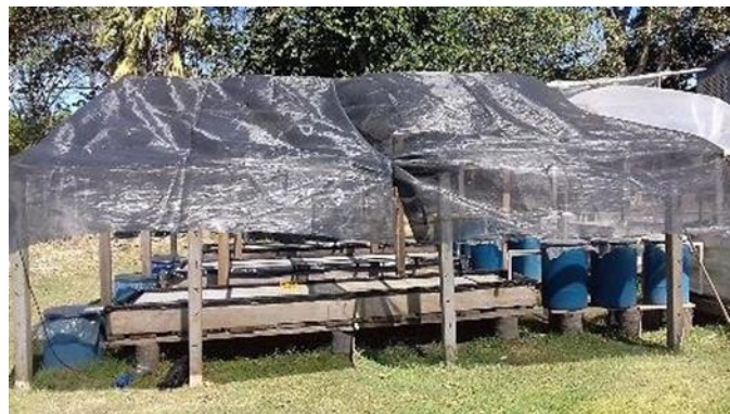
Figura 10. Techo cubierto con tela sarán para proteger del sol.
