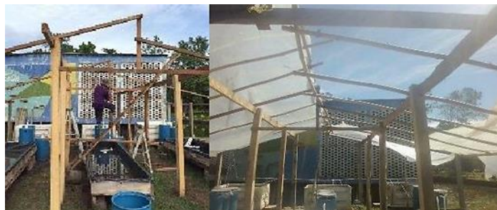
Figura 9. Techo de madera de dos aguas asimétrico.
