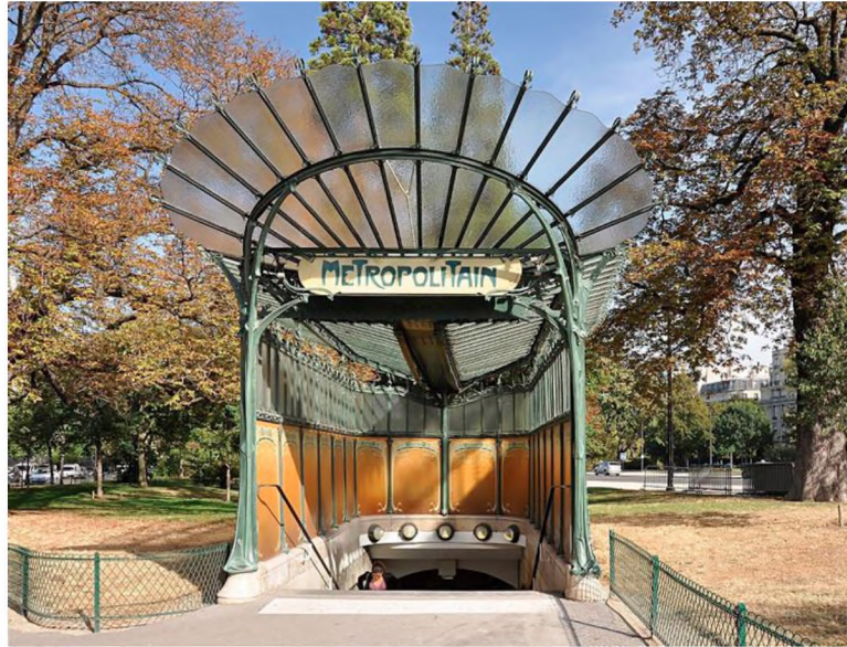
Figura 19: Entrada de la estación de metro Porte Dauphine en París.
