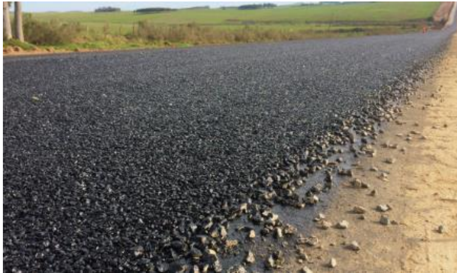
Ilustración 2.2-15 Tratamientos Superficiales. Fuente: Imagen tomada de la página web de empresa BITAFAL.
