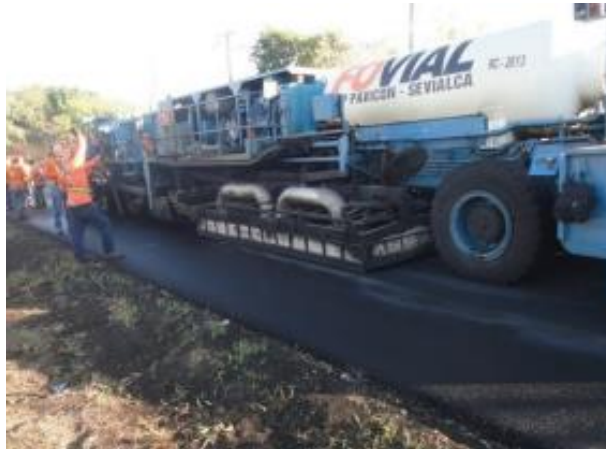
Ilustración 2.3-11: Colocación inicial de la Recicladora, Est 9+000 Fuente: Tesis (2022) Manual del proceso constructivo para la colocación de carpeta asfáltica, utilizando la técnica de reciclado en caliente in situ, para mejorar el desempeño del pavimento existente en la carretera CA08W, en el tramo desde Ahuachapán Centro, a partir del desvío de Ataco hasta la frontera Las Chinamas, dpto. de Ahuachapán.
