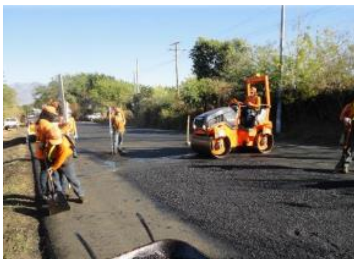
Ilustración 2.3-19: Compactación en bordes y ángulos de reposo. Fuente: Tesis (2022) Manual del proceso constructivo para la colocación de carpeta asfáltica, utilizando la técnica de reciclado en caliente in situ, para mejorar el desempeño del pavimento existente en la carretera CA08W, en el tramo desde Ahuachapán Centro, a partir del desvío de Ataco hasta la frontera Las Chinamas, dpto. de Ahuachapán.
