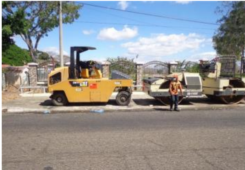
Ilustración 2.3-20: Sellado con Rodo Neumático.
