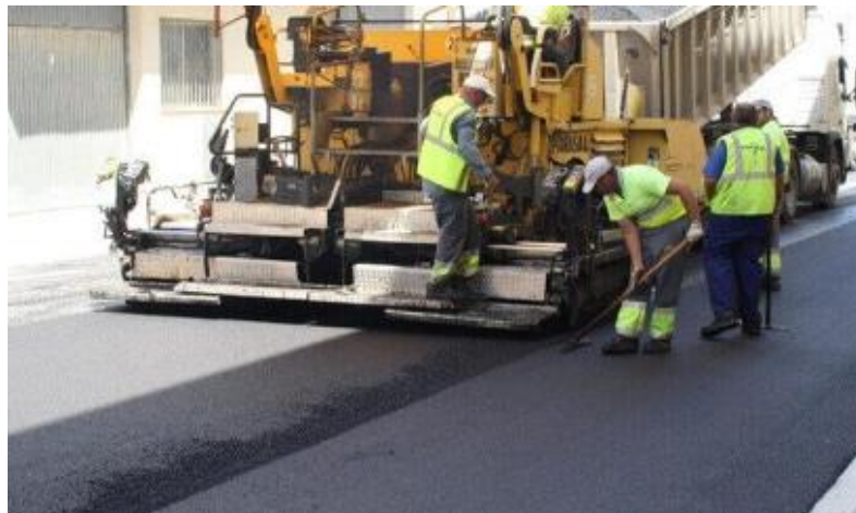
Ilustración 2.2-12 Mezcla asfáltica en frío.
