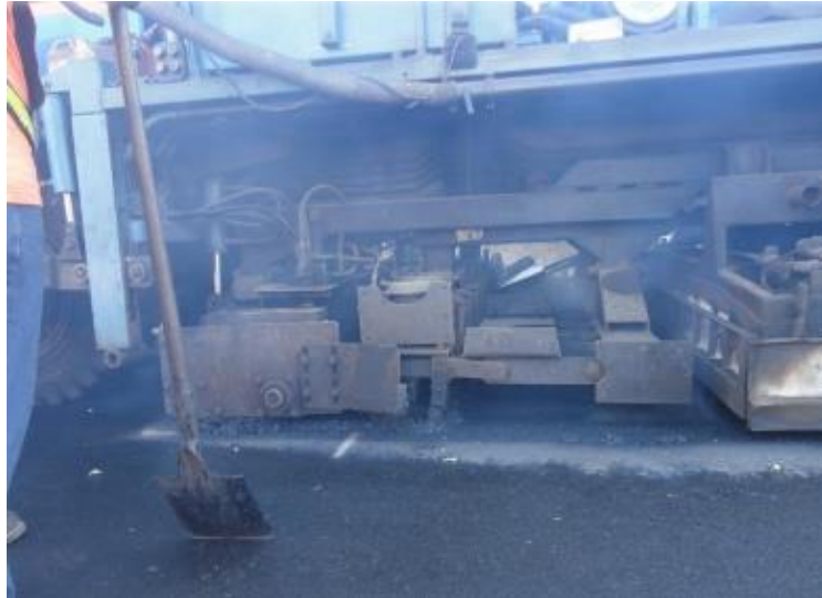
Ilustración 2.3-12: Colocación de escarificadores.
