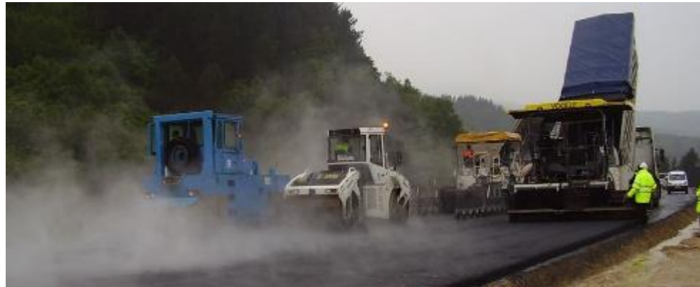
Ilustración 2.2-13 Mezcla Asfáltica en Caliente.
