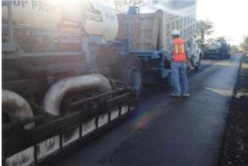
Ilustración 2.3-15: Abastecimiento de Mezcla Virgen, Est 0+900 Fuente: Tesis (2022) Manual del proceso constructivo para la colocación de carpeta asfáltica, utilizando la técnica de reciclado en caliente in situ, para mejorar el desempeño del pavimento existente en la carretera CA08W, en el tramo desde Ahuachapán, a partir del desvío de Ataco hasta la frontera Las Chinamas, dpto. de Ahuachapán.
