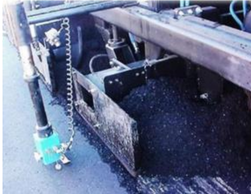
Ilustración 2.3-16: Esparcimiento Final de la Mezcla, Est 9+000. Fuente: Tesis (2022) Manual del proceso constructivo para la colocación de carpeta asfáltica, utilizando la técnica de reciclado en caliente in situ, para mejorar el desempeño del pavimento existente en la carretera CA08W, en el tramo desde Ahuachapán Centro, a partir del desvío de Ataco hasta la frontera Las Chinamas, dpto. de Ahuachapán.
