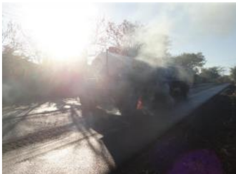
Ilustración 2.3-10 Precalentamiento inicial, Est 9+000. Fuente: Tesis (2022) Manual del proceso constructivo para la colocación de carpeta asfáltica, utilizando la técnica de reciclado en caliente in situ, para mejorar el desempeño del pavimento existente en la carretera CA08W, en el tramo desde Ahuachapán Centro, a partir del desvío de Ataco hasta la frontera Las Chinamas, dpto. de Ahuachapán.
