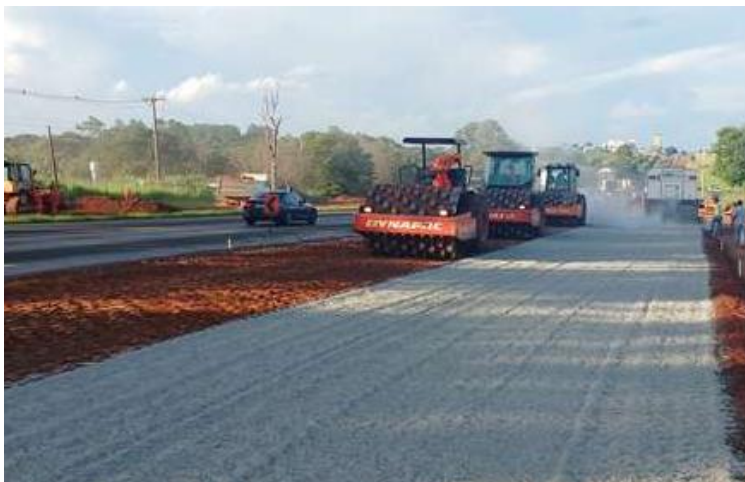
Ilustración 2.2-10 Estabilización con Cemento.
