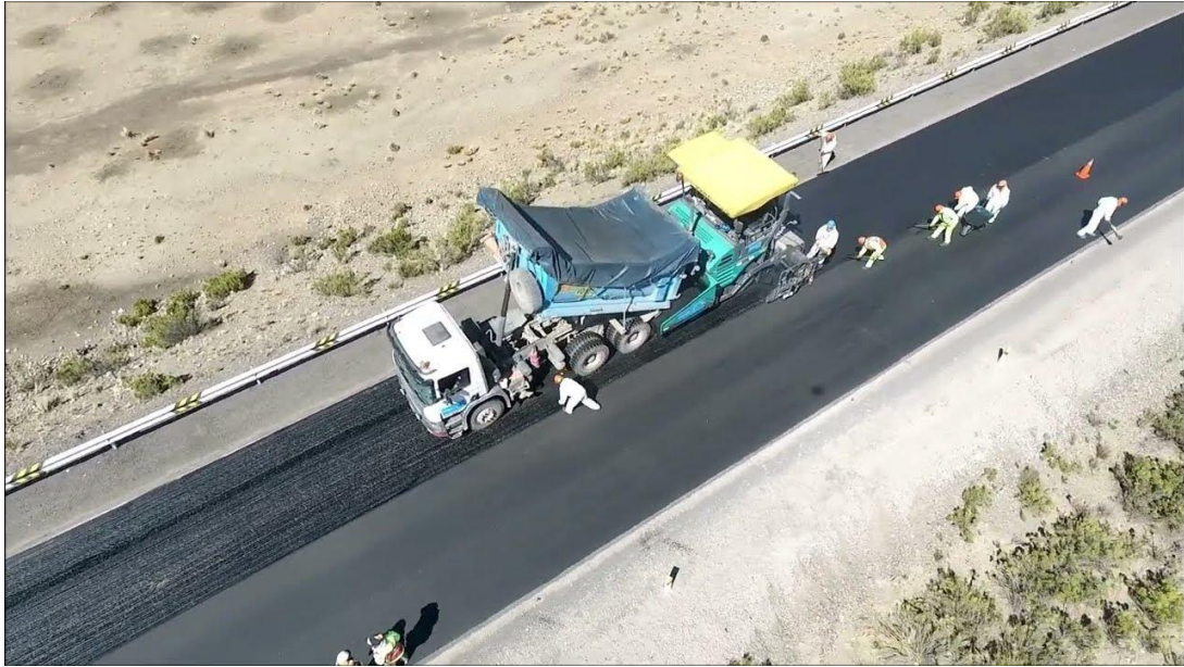
Ilustración 2.2-14 Colocación de mezcla asfáltica tibia.
