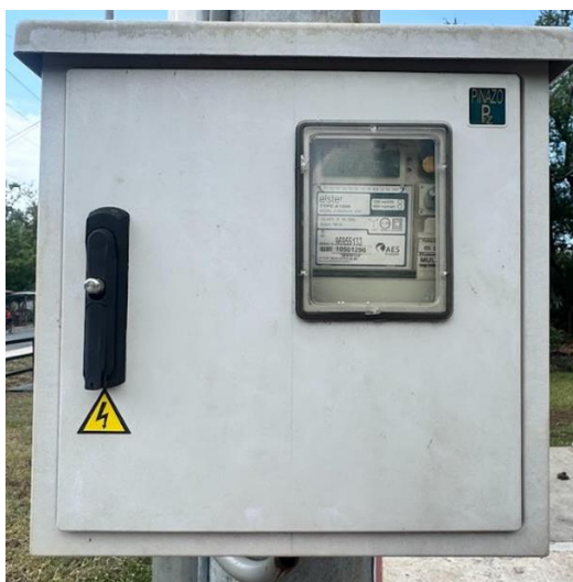
Figura 39 Medidor Elster A1800. Nota: Fotografía capturada por el autor (2025).
