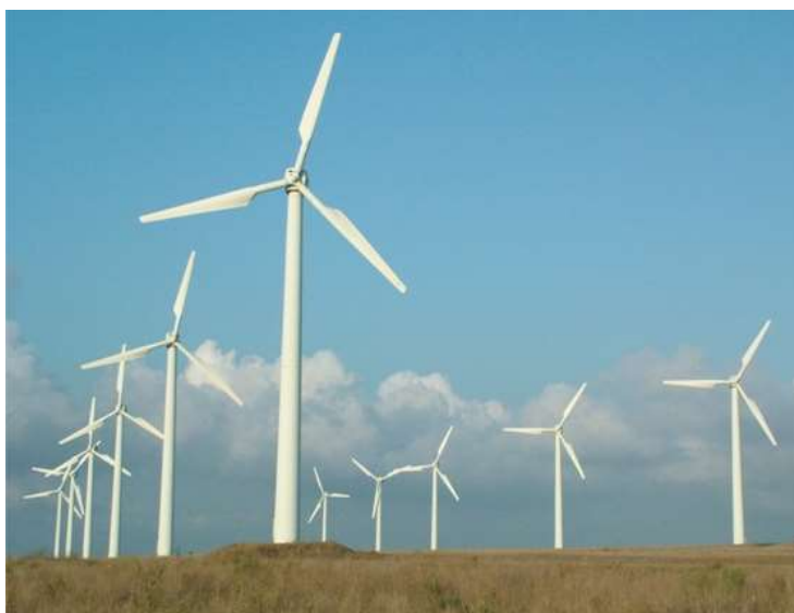
Figura 2.3 – Generador eólico de eje horizontal (persio9020, 2013)(4)
