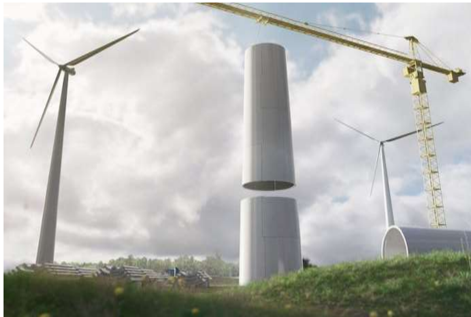
Figura 2.6 – Armazón de torre de un aerogenerador (Comision Europea, 2020)(12)
