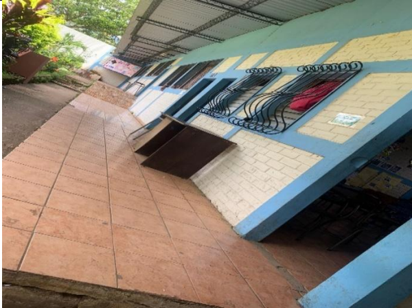
Foto 3: Pasillo de aulas de primer y segundo año de bachillerato
